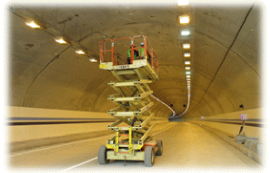
터널 초기점검 (고소차 점검)
