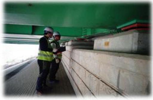
교량 정밀점검 현황 (외관조사)
