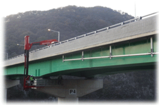
교량 초기점검 현황 (굴절차 점검)
