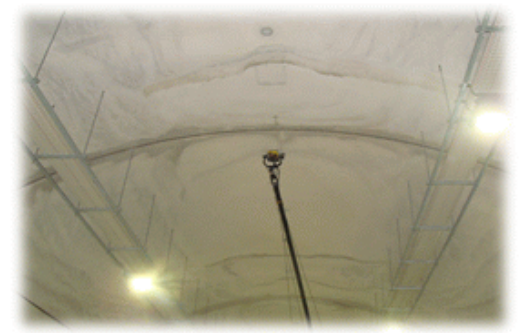
터널 정밀안전진단 현황 (G.P.R 탐사)
