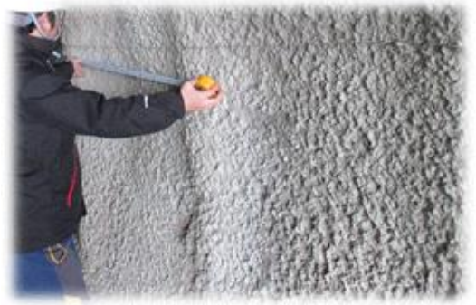
터널 공사중점검 현황 (제원조사)
