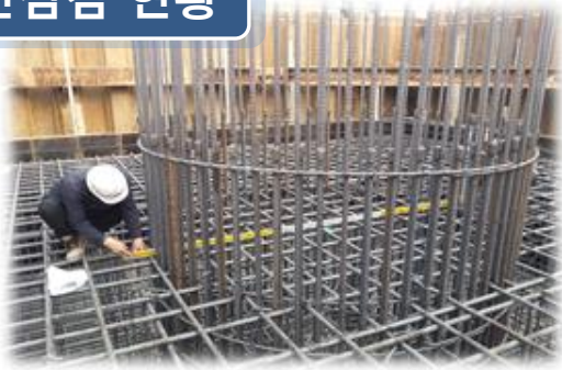
교량 공사중점검 현황 (제원조사)
